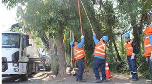
*Figura 18.* Personal de Consorcio Cam Lima podando antes de realizar trabajos de media y baja tensión.
