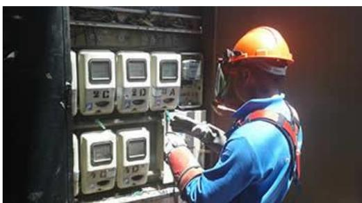
*Figura 5. Personal de Consorcio Cam Lima realizando trabajo de Corte y Reconexión.*
