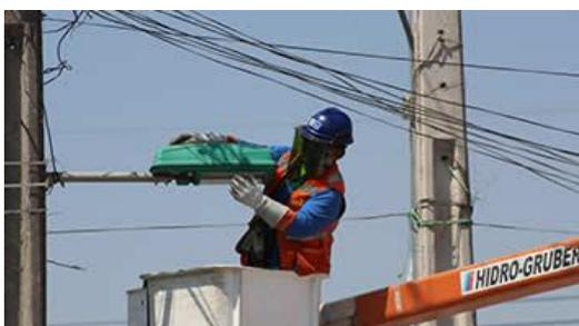
*Figura 17.* Personal de Consorcio Cam Lima realizando trabajo de mantenimiento de luminarias públicas en un poste.
