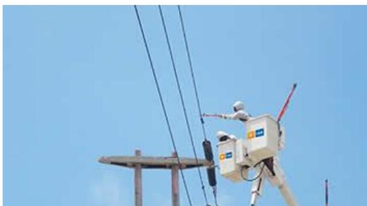
*Figura 15.* Personal de Consorcio Cam Lima realizando trabajo de Líneas Energizadas.
