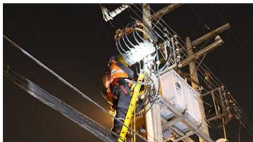
*Figura 20.* Personal de Consorcio Cam Lima realizando trabajo de emergencia ante un incidente a consecuencia de un cortocircuito.
