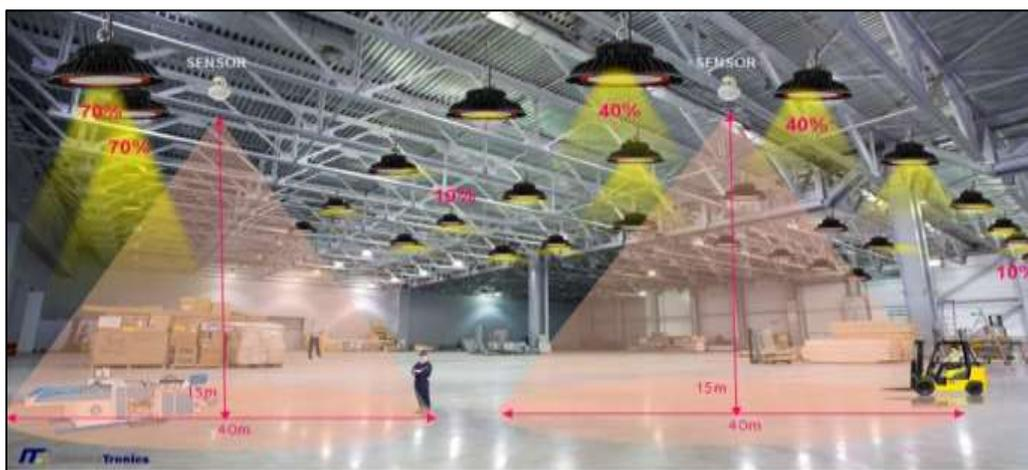
*Figura 33* Iluminación con sensor atenuable (Iluminación enciende en zonas con movimiento en proporción a la luz natural. Adatado de Google imagen.
