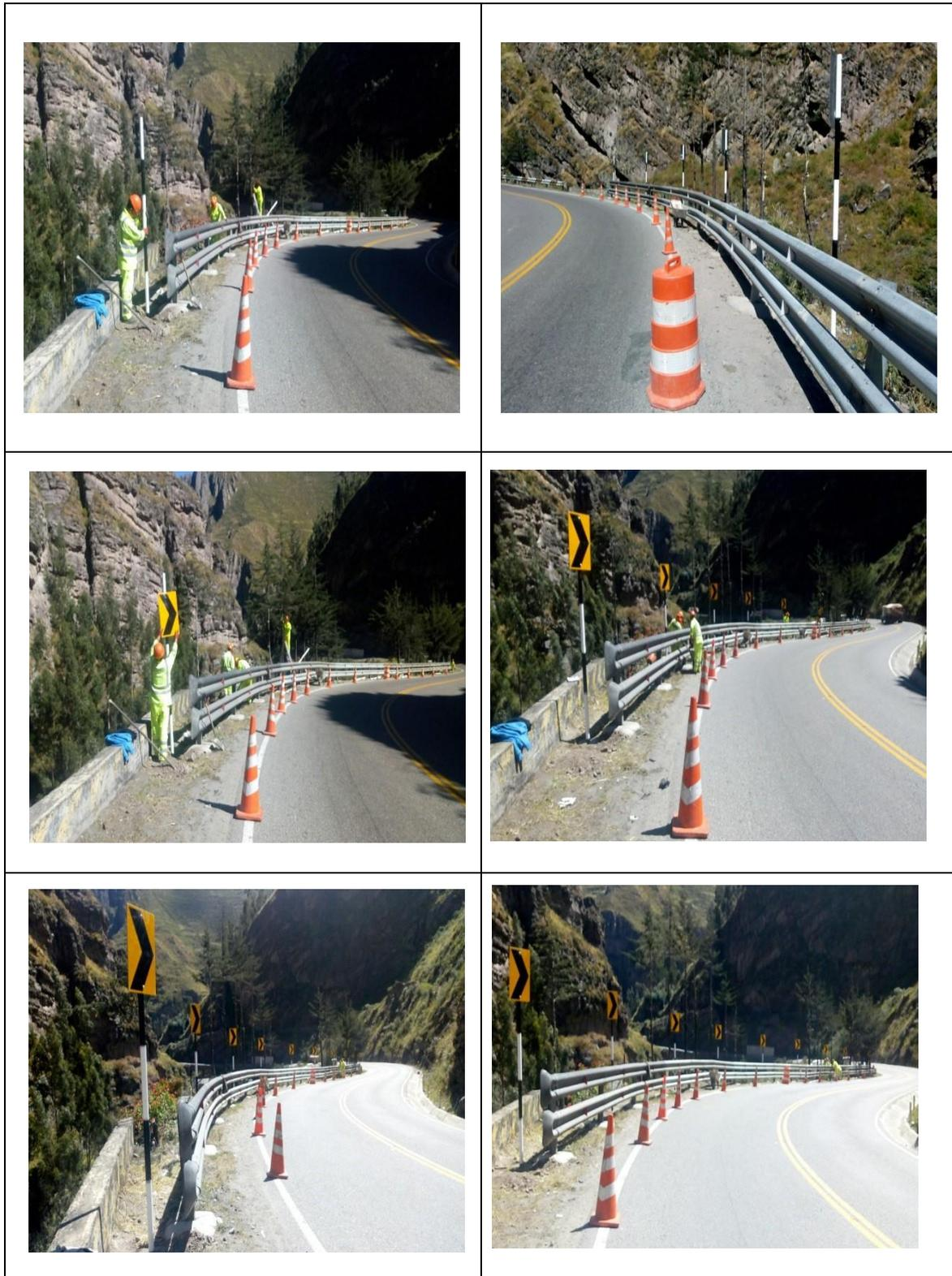
Figura 28. Instalación de señales verticales tipo chevrón.
