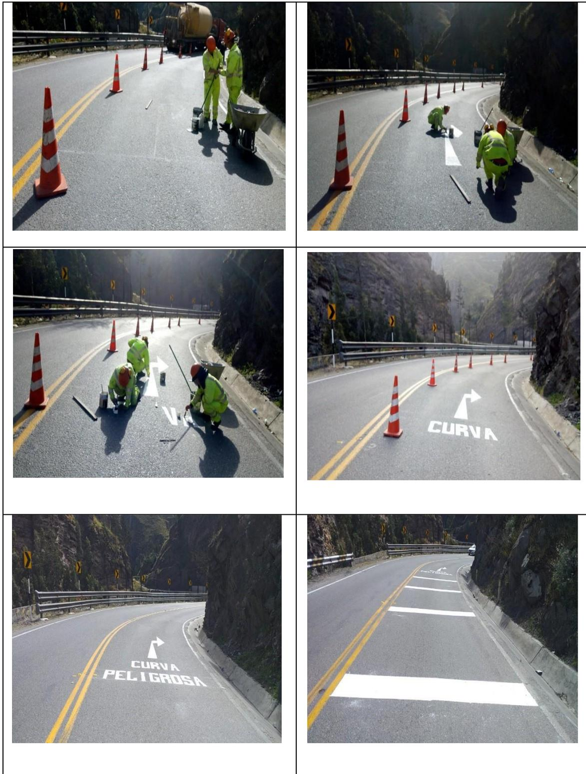
Figura 29. Señalización horizontal – Marcas en el pavimento.
