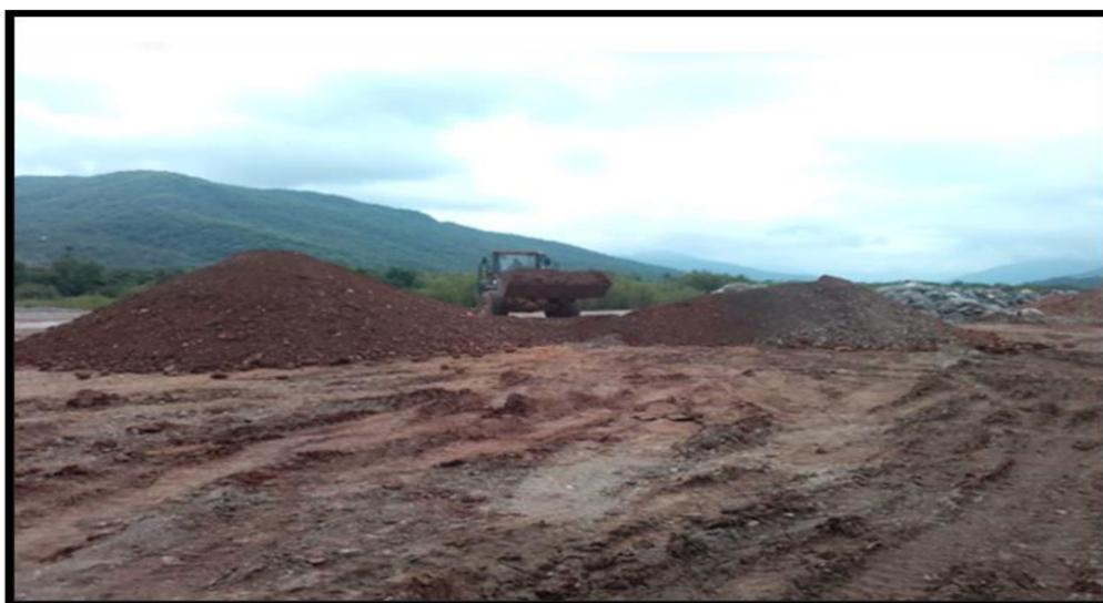
Figura 48. Batido de arcilla con hormigón en cantera Huarmaca, al costado de la ejecución de obra.
