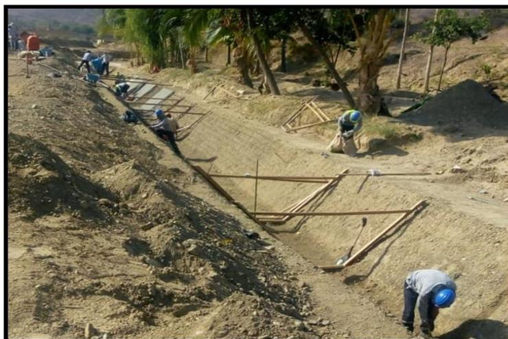
Figura 60. Colocación de cerchas a medida que se vacea los tramos del canal.
