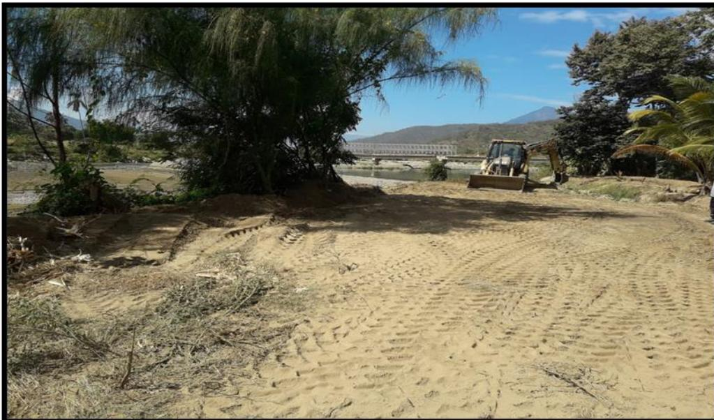
Figura 39. Limpieza de terreno con retroexcavadora en el canal de irrigación
