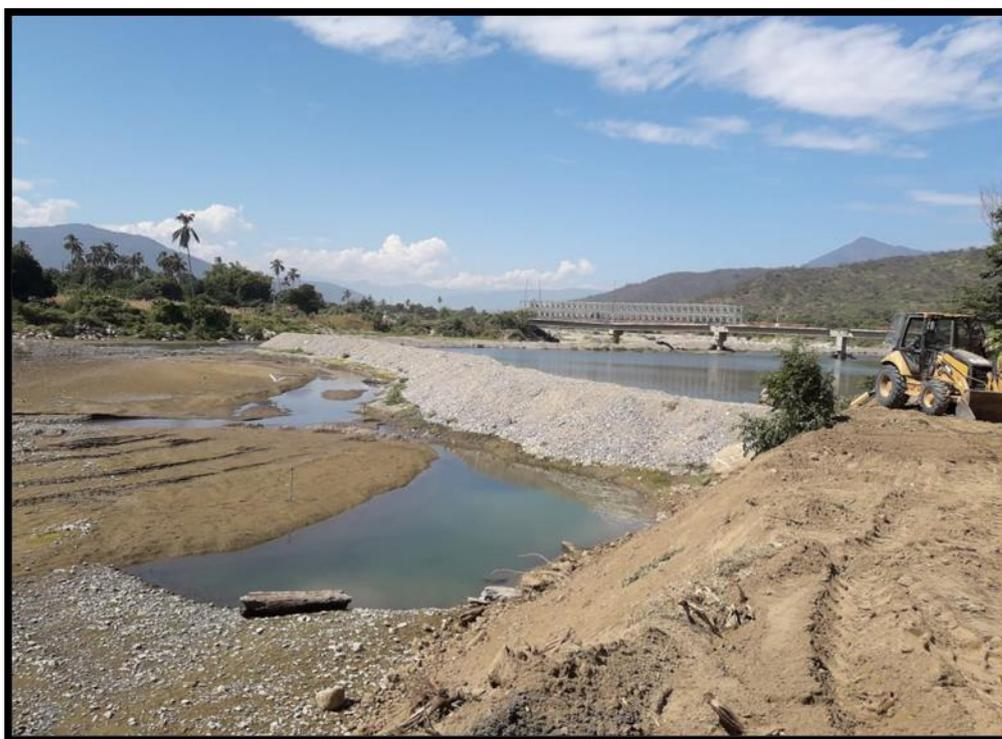
Figura 33. Construcción de diques con retroexcavadora en ejecución de obra de Canal de Periquillo
