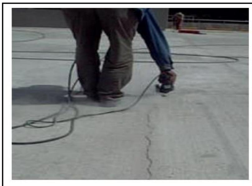
Figura 24. Fisuras ranuradas
