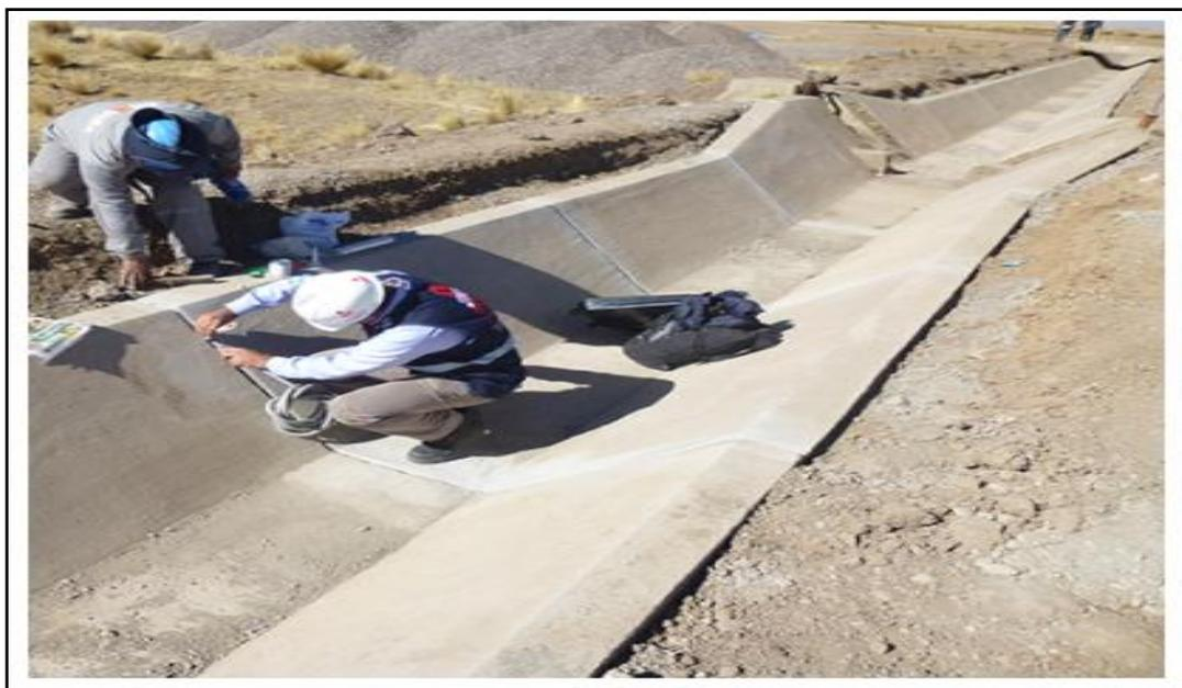
Figura 73. Sellado de juntas con aditivo.
