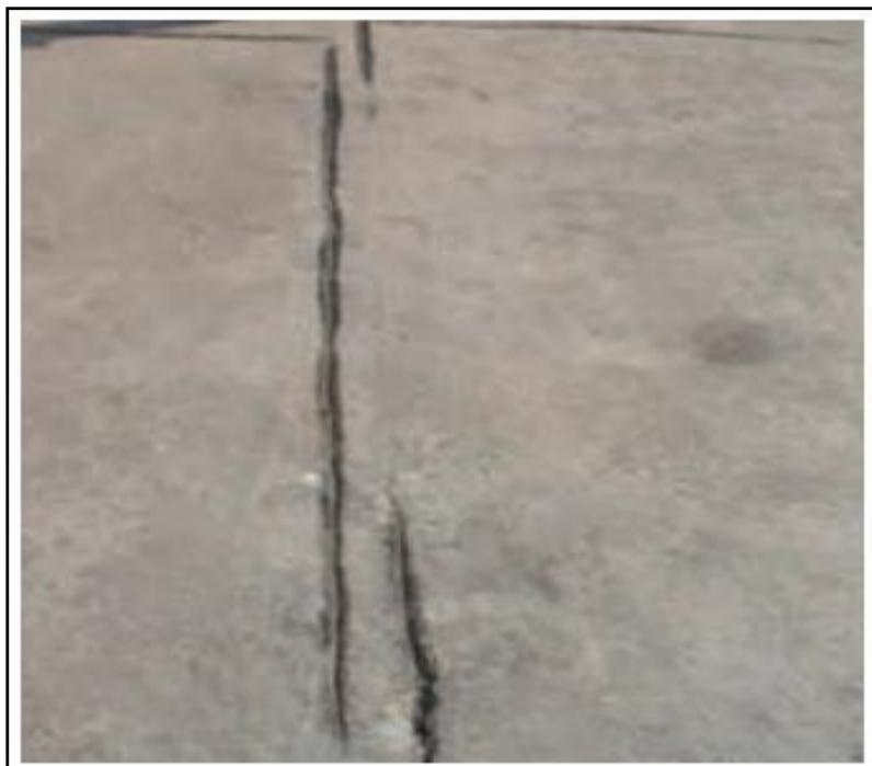
Figura 25. Sellado de la fisura con producto elastomérico.
