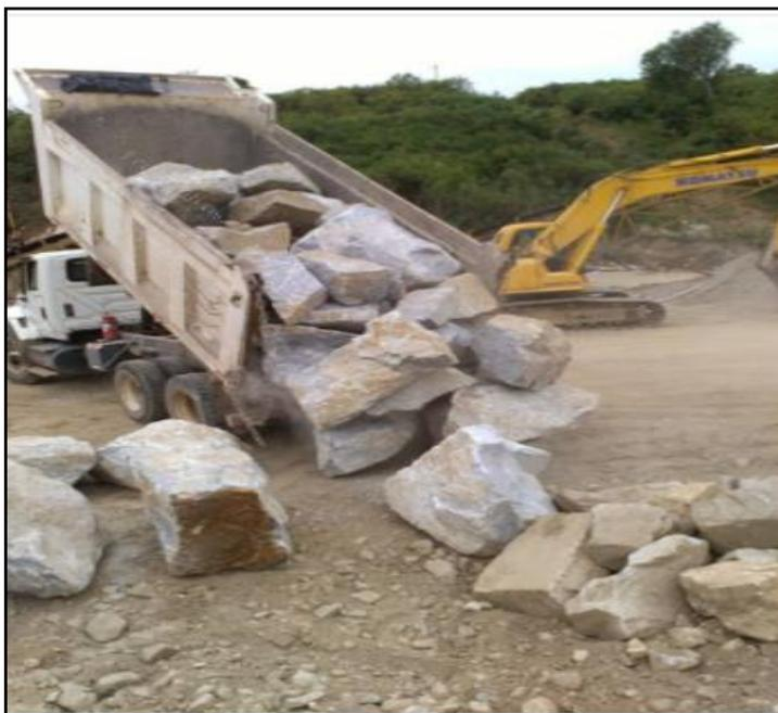
Figura 14. Extracción de rocas en quebrada para su colocación en desvío de río
