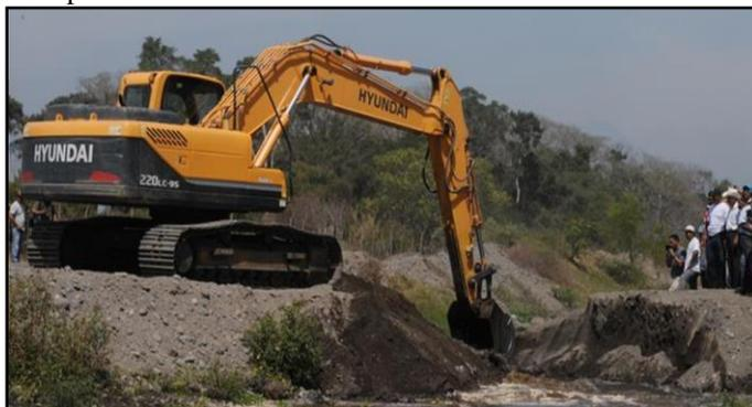
**Colocación de bolsas de arena en aguas arriba del Río:** Luego del trabajo de la excavadora hidráulica, cargador frontal o retroexcavadora se continúan los trabajos de colocación de sacos de arena los cuales son realizados con mano de obra no calificada, de tal manera que es importante que en la colocación de sacos estén bien colocados evitando el paso del agua; como se puede apreciar el acomodo de sacos en la Figura 12.
