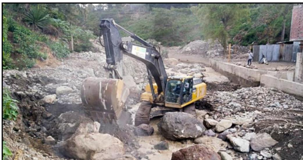
**Colocación de Rocas en aguas arriba:** Luego de haber extraído las rocas en cantera privada o quebrada se procede a colocar la roca en aguas arriba con excavadora hidráulica de manera uniforme de tal manera que se pueda evitar el paso del agua al lugar de construcción de canal. Se puede apreciar el colocado de roca en la Figura 15.
