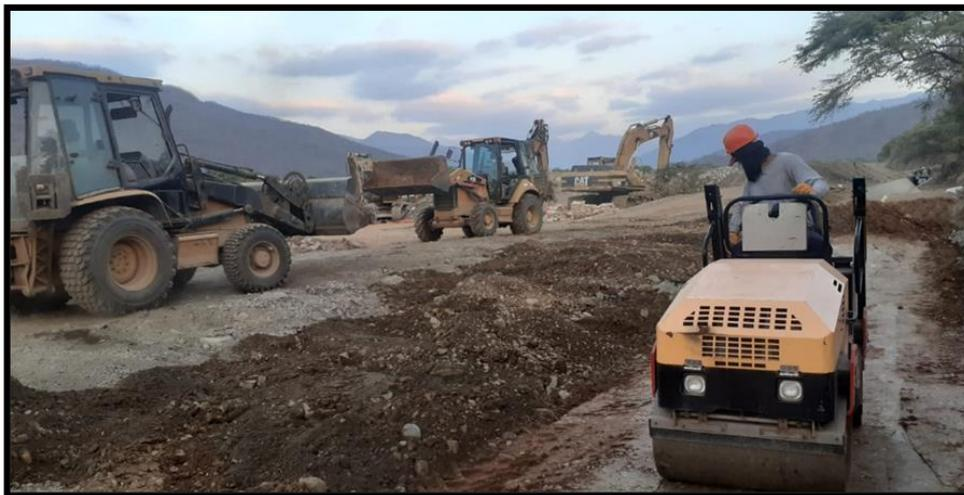
Figura 52. Dirección de Residente de obra en trabajos de Compactación en Canal de Periquillo.
