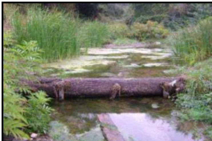
**Colocación de troncos:** El proceso de colocación de tronco generalmente se realiza con mano de obra de la zona debido que es un trabajo rápido y eficaz para utilizar como un dique de tal manera se pueda trabajar en la ejecución de canal de irrigación. En la figura 19 se puede apreciar la colocación de troncos para evitar el paso de agua y de esta forma poder construir el canal de irrigación.
