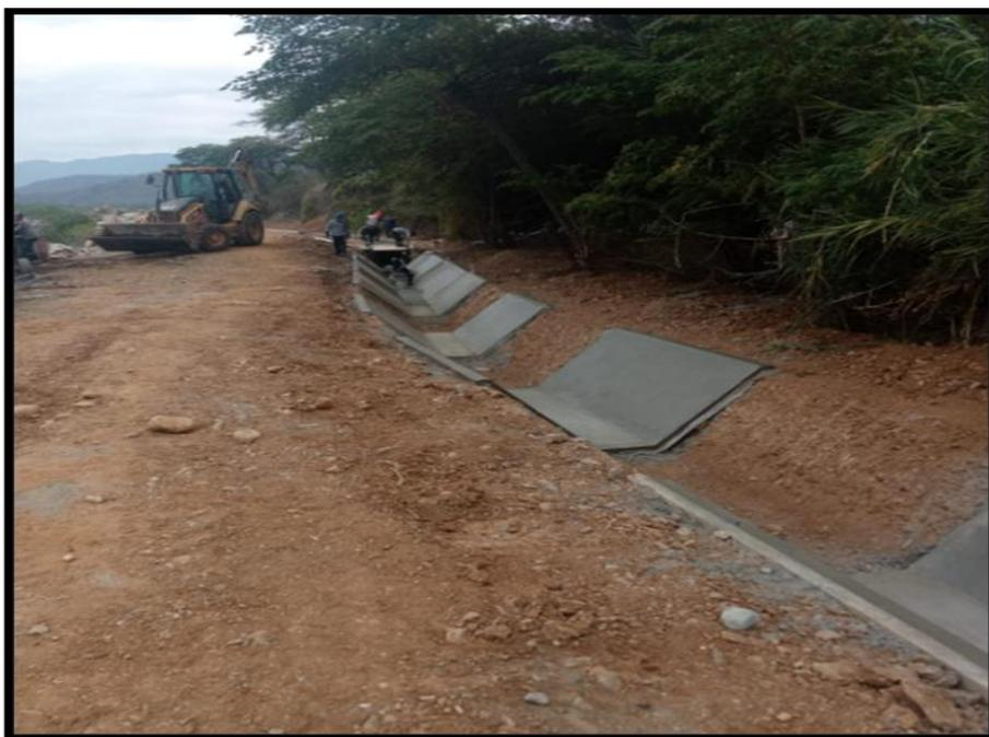
Figura 62. Trabajos de nivelación con regla.
