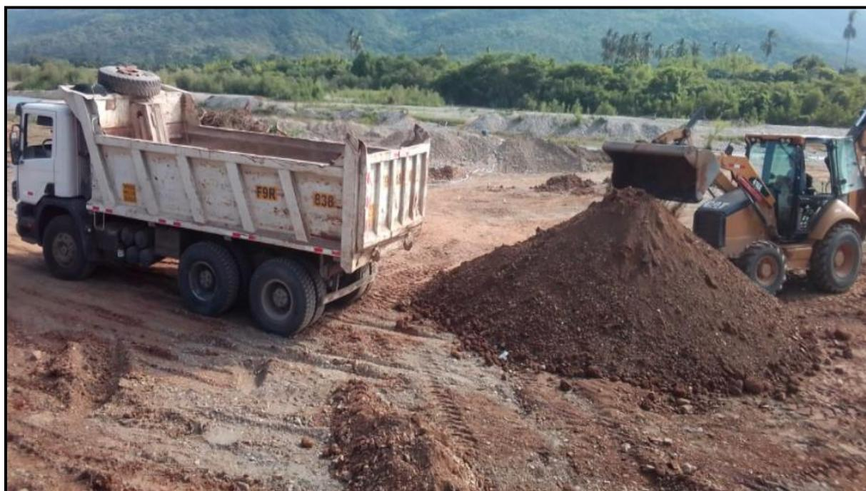
Figura 50. Descarga de afirmado en el Canal de Periquillo.
