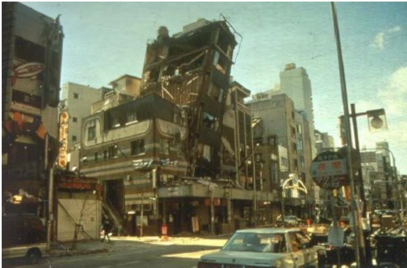
*Figura 4.* Edificios como este edificio de oficinas en Kobe, Japón, son generalmente inestables y pueden colapsar en una réplica. Adaptado de “Earthquake Aftershocks – Entering Damage Buildings”.
