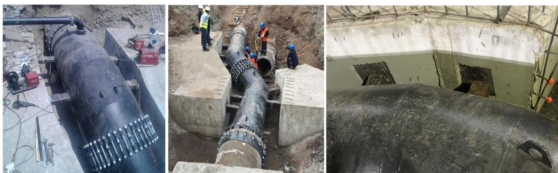
Figura 24. Pre-anclajes en empalmes de Tubería Ø1000 y Ø1600
