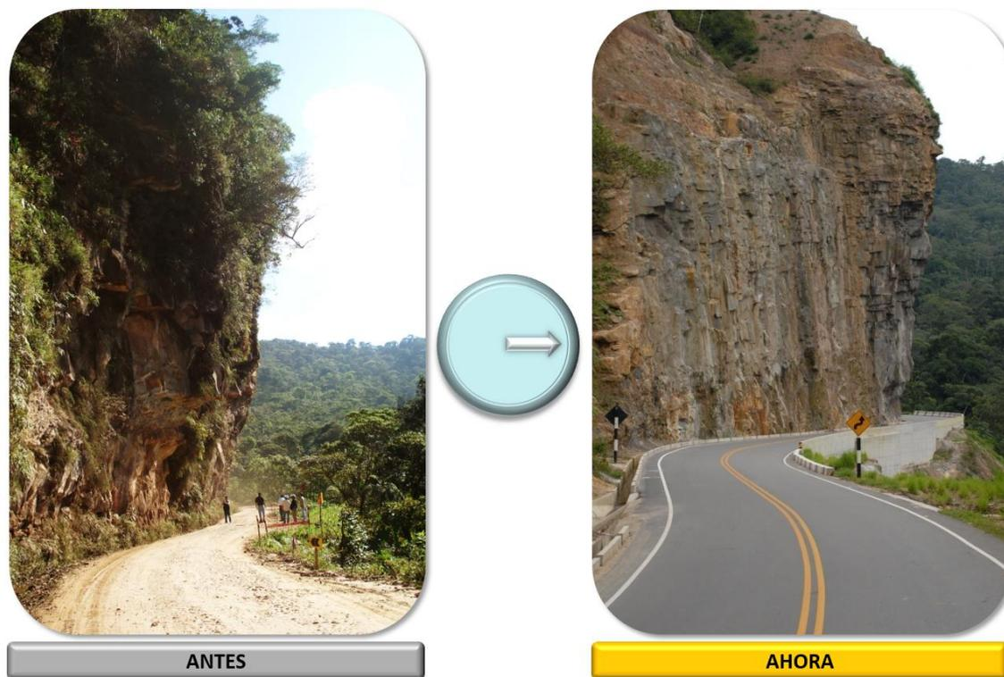
Figura 21. Evitar el corte de la ladera de cerro – Zona “Paredón”
