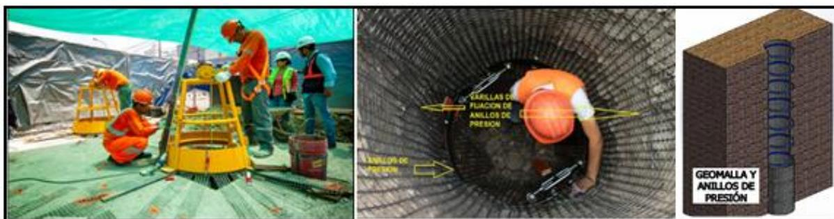
Figura 23. Ejecución de Pilotes manuales.
