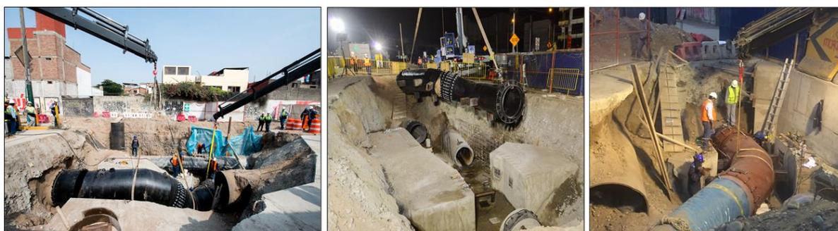
*Figura 12.* Reubicación de Tubería Matriz de Agua  $\phi 1000$ ,  $\phi 1600$  y tubería de desagüe  $\phi 1200$
