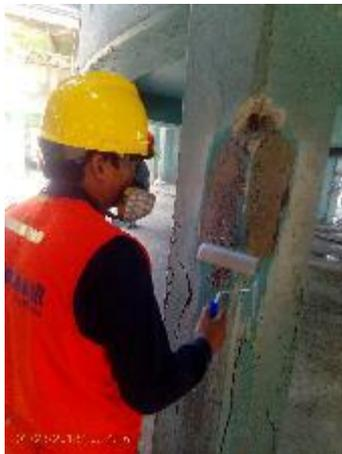
Figura 34: Humedecimiento de la superficie del elemento estructural. Fuente propia
