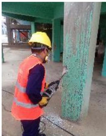
Figura 31: Confección de regata de elemento estructural hasta encontrar acero de refuerzo. Fuente propia
