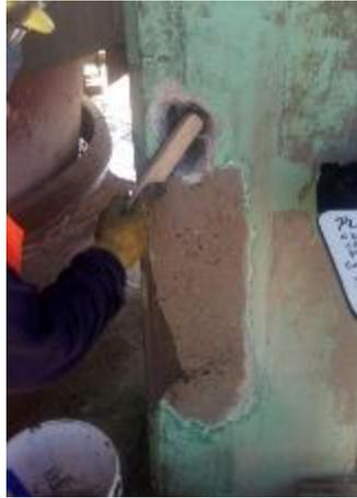
Figura 33: Limpieza del refuerzo del elemento estructural. Fuente propia
