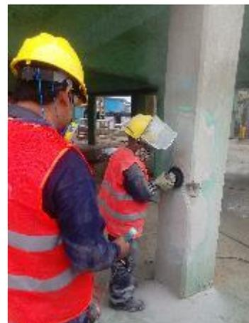
Figura 32: Escarificado y limpieza de la parte superficial del elemento estructural. Fuente propia
