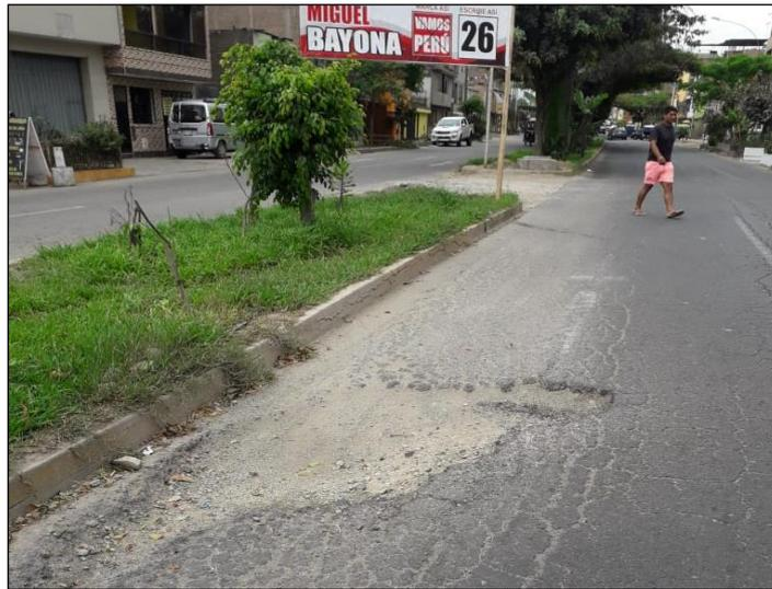
*Imagen 18. Pavimento deteriorado. Av. Camino Real.*
