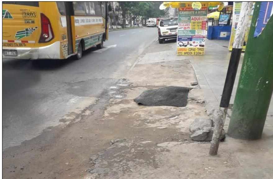
*Imagen 17. Berma deteriorada. Av. Eucaliptos.*
