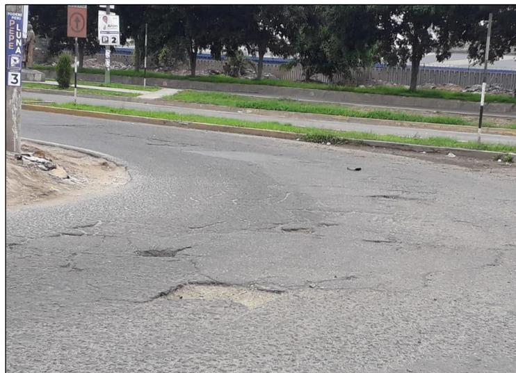
*Imagen 19. Pavimento deteriorado. Av. camino Real cruce Av. Ruiseñores.*
