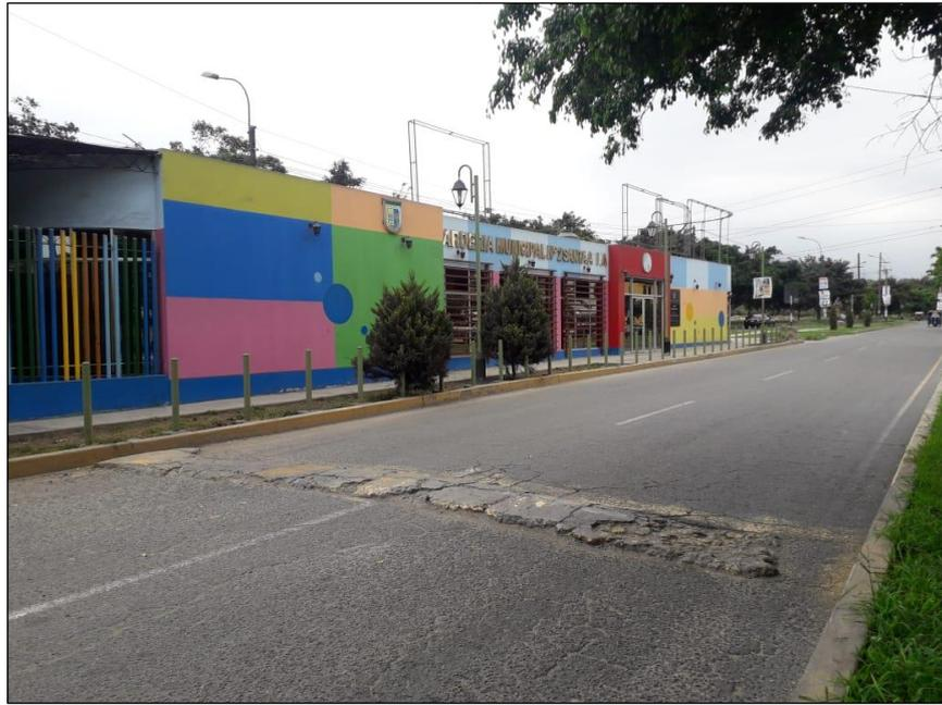
*Imagen 20. Reductor de velocidad en mal estado, Av. Camino Real.*
