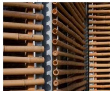
Celosías de Bambú que permiten la reorientación de la luz natural disminuyendo así la utilización de iluminación artificial. Logrando de esta manera la reducción del consumo energético controlando las ganancias del calor.
