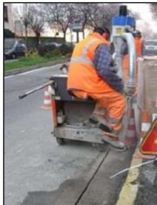
*Figura 20.* Cortado de la microzanja.
