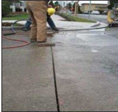
*Figura 21.* Canalización de fibra óptica con microzanjas.
