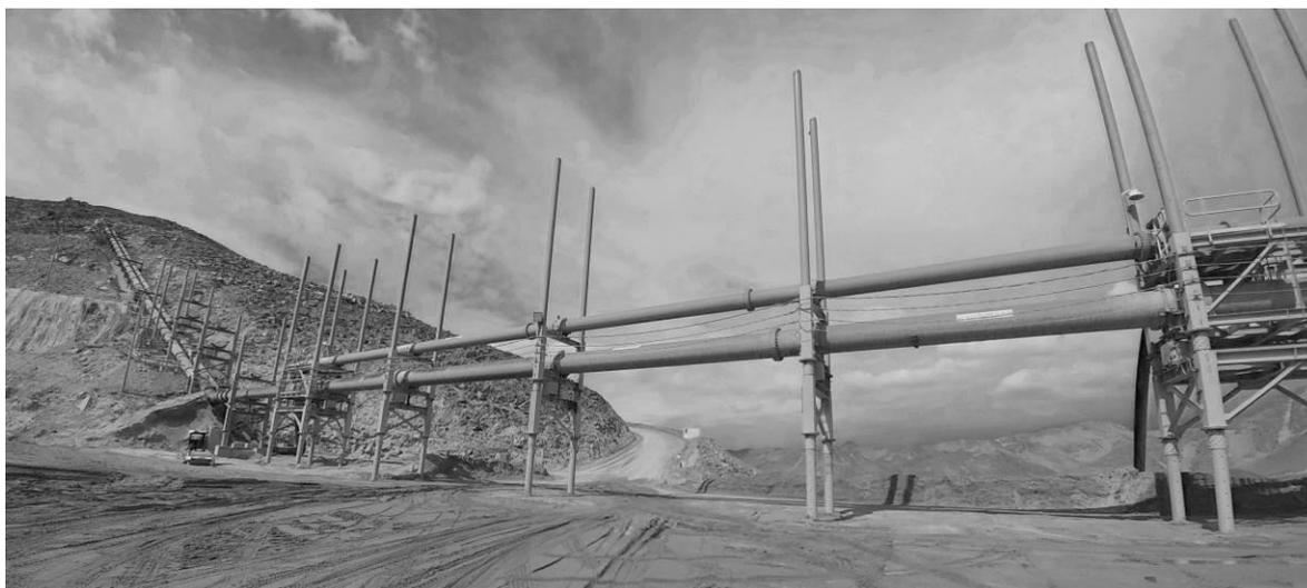
*Figura 55.* Tuberías para el traslado de relaves a poza de lixiviación en Mina – Arequipa 2018. Tomado de Archivo Personal de Peters Johnson.
